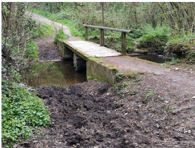
Photo 10: Passerelle sur l'Hocmard, les cavaliers passent à gauche dans le ruisseau
