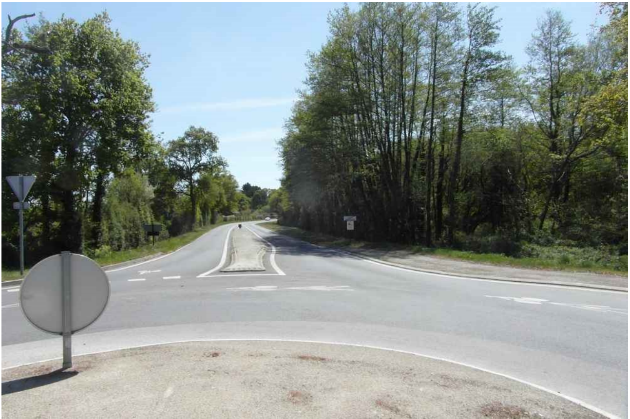
Figure 1.4 : Début de la route vue du giratoire de Logné (au fond le virage de Logné)
