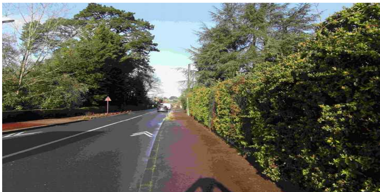
Photo 1 ci dessus : début du tronçon vu du giratoire de la Papinière
