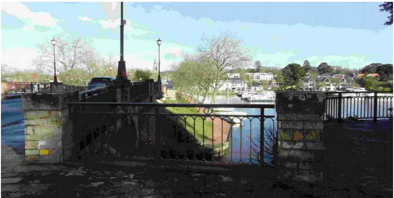
Photo 3 : ci dessus vue du franchissement de l'Erdre vers le nord
