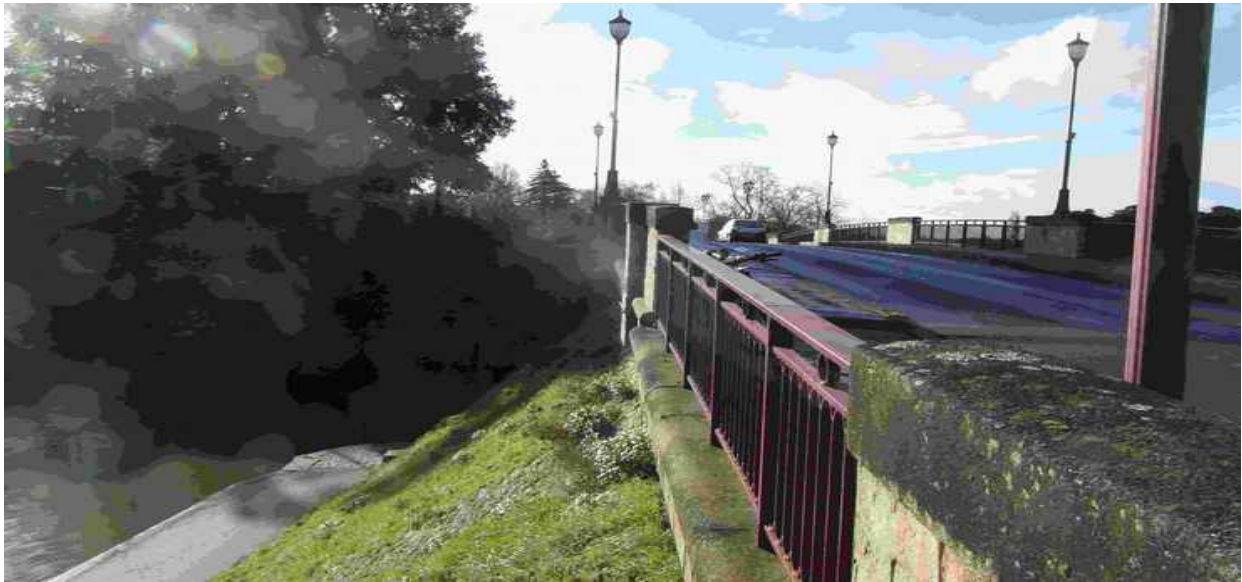
Photo 2 : ci dessus vue du franchissement de l'Erdre vers le sud
