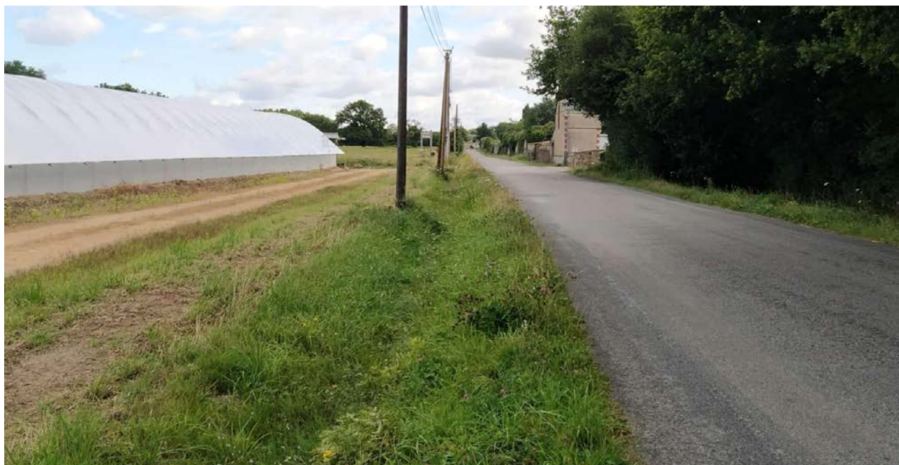
Photo 3 : Le secteur de la Petite Gâcherie et la possibilité d'une emprise au ras des poteaux
