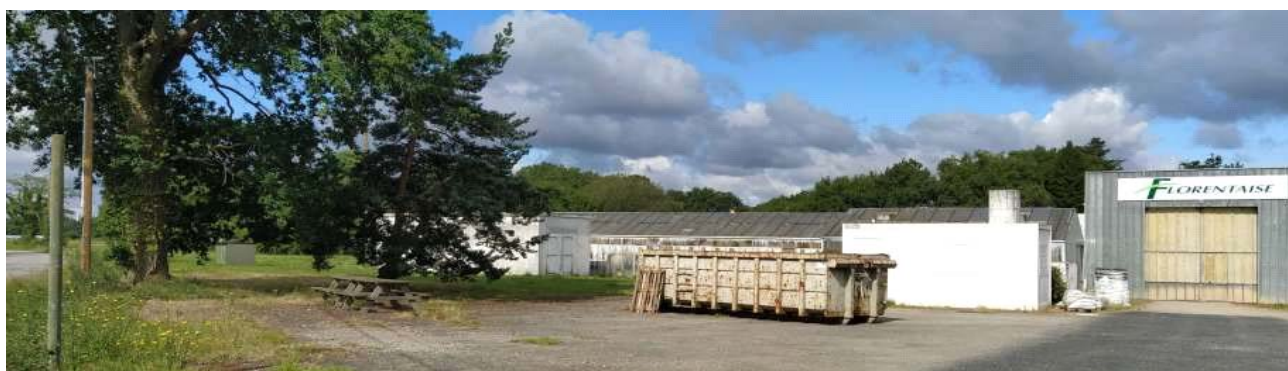
Photo 4 : Le transformateur et les abords de la Florentaise
