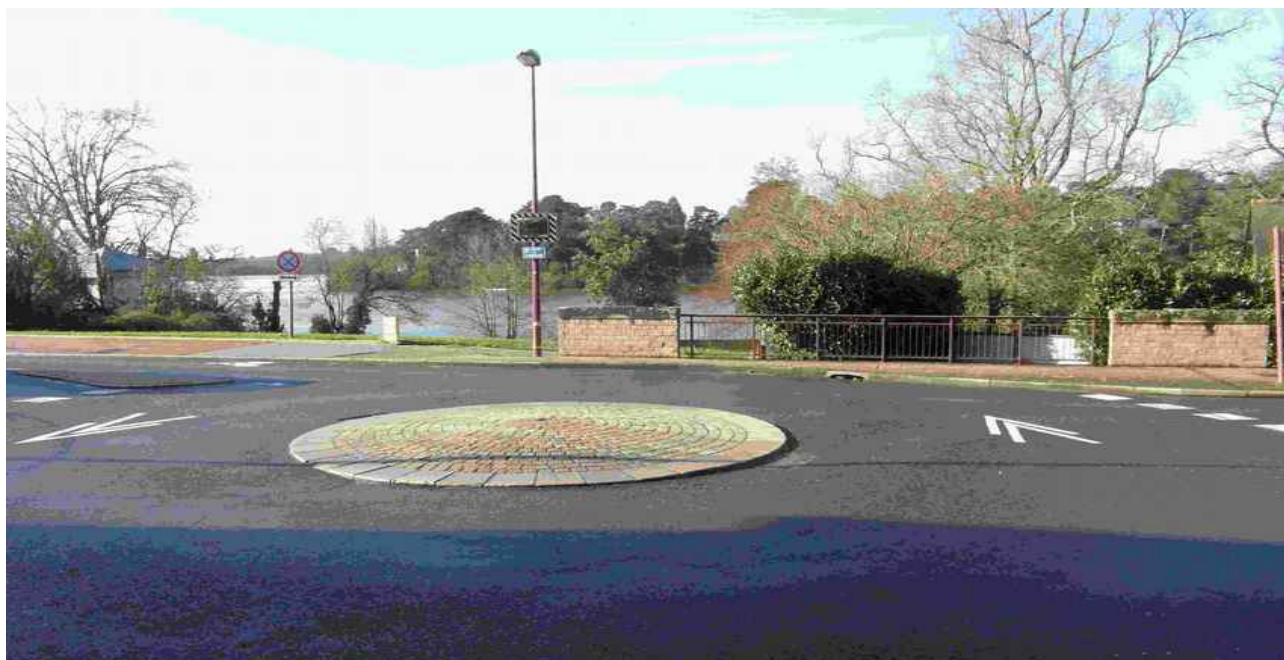
Photo 1 : ci-dessus vue du giratoire et de l'étroitesse du trottoir à l'opposé
