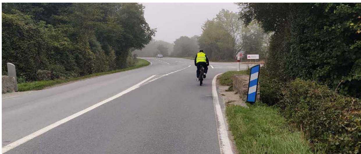
Photo 11 : Le pont sur le ruisseau de St Médard juste avant l'accès aux carrières
