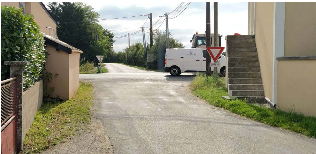
Photo 7 : Beauchêne : le franchissement de la D178
