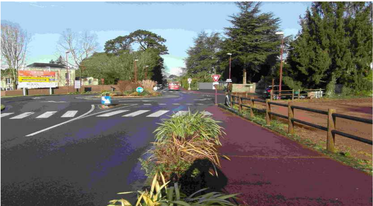
Photo 1 : ci-dessus vue du giratoire et de la clôture
