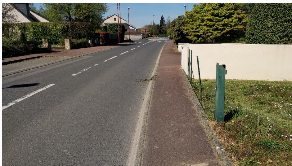
Figure 10.25 : Passage le plus étroit de la rue, à élargir grâce à une réduction de la chaussée
