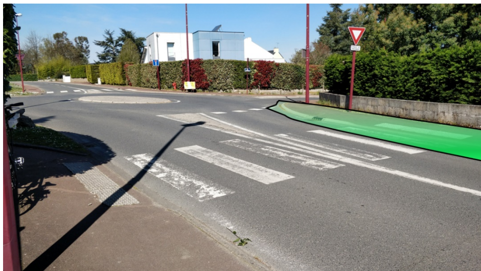
Figure 10.26 : Raccordement sur le giratoire de la Miltière
